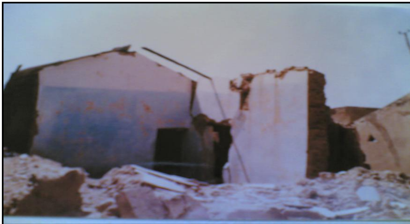
Photo 5. Dommages subis par un bâtiment en banco revêtu de ciment à Podor
