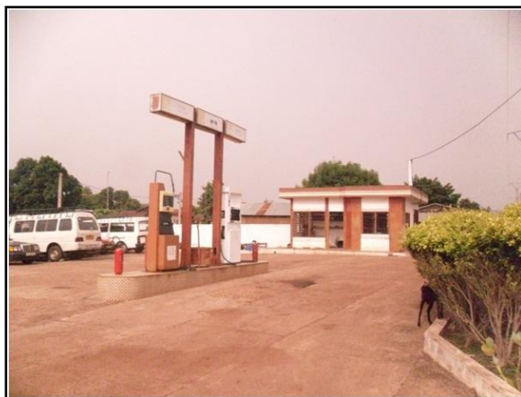
Photo 1: Station d'essence Cap de Kétao
